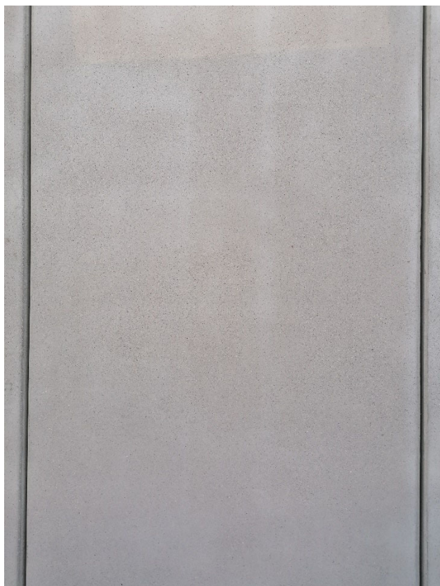
Konstantní šířky svislých spár, zkosení hran bez otřepů.
